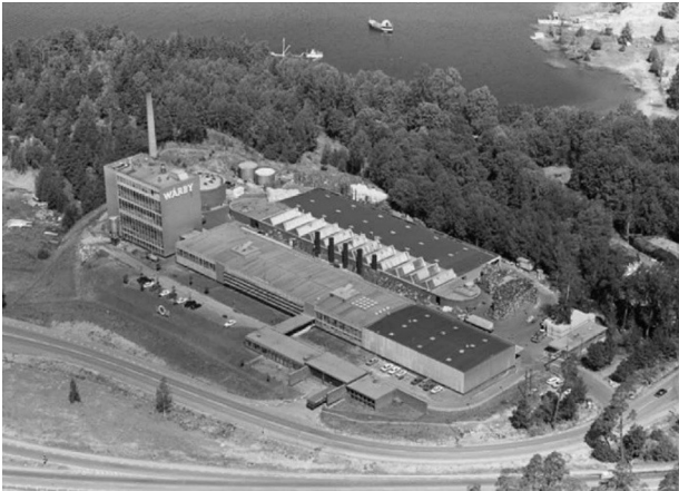
Fig. 6 Demonstration project Vårby Udde, Stockholm (Image by: Magnolia Bostad)
