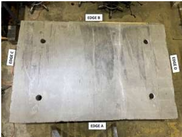
A) S1 soffit.
