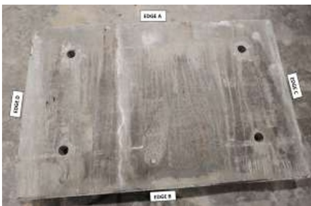
B) S7 soffit.
