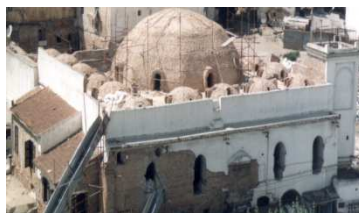
Fig 4. Photo de la mosquée pendant les travaux.
