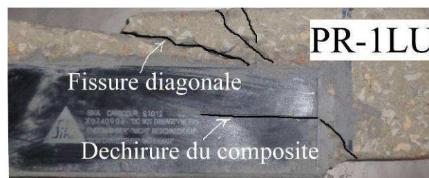
Fig. 9. Mode de rupture de la poutre PR-1LU.
